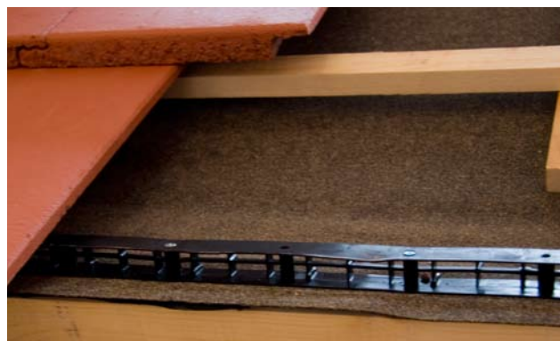
Bild 2. Montering av Ventilerad takfotsläkt
